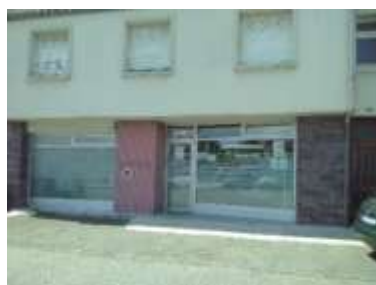
Local Pôle social coté Boulevard Branly
